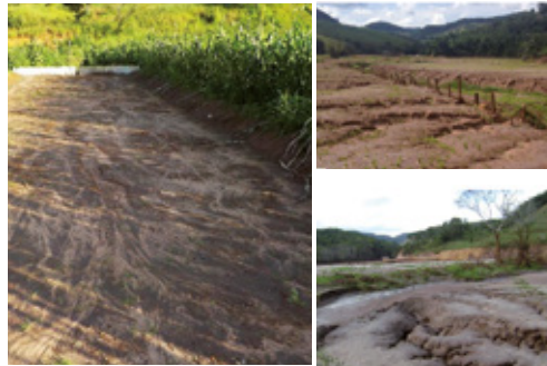
Figura 38 – Registros fotográficos de processos erosivos nas áreas de deposição do rejeito (processos de erosão laminar e erosão em sulcos).
