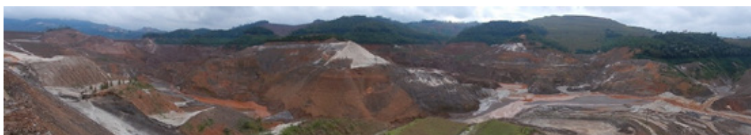
Figura 3 – Fotografia panorâmica da cava da barragem de Fundão em 03/05/2017.
