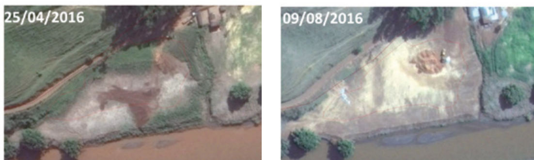
Figura 46 – Imagens de satélite indicando a adição de solo de empréstimo sobre áreas de deposição de rejeito. Fotos: coordenadas: 20°16'48.57" S e 43°2'20.82" O, nas datas de 25/04/2016 e 09/08/2016, respectivamente.
